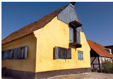
Tekstiler i underetagen og handelsudstyr på loftet.
