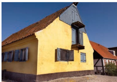
Tekstiler i underetagen og handelsudstyr på loftet.
